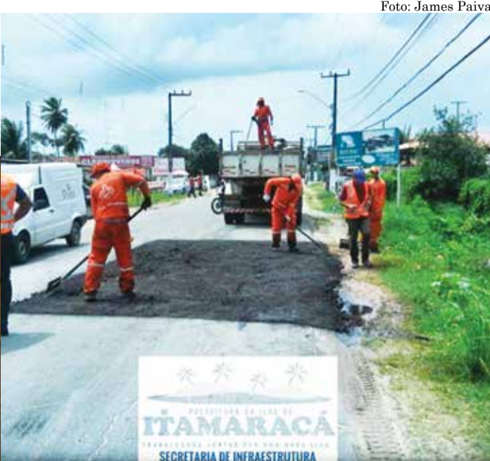
OBRAS Equipe do DER consertando asfalto da PE-35
